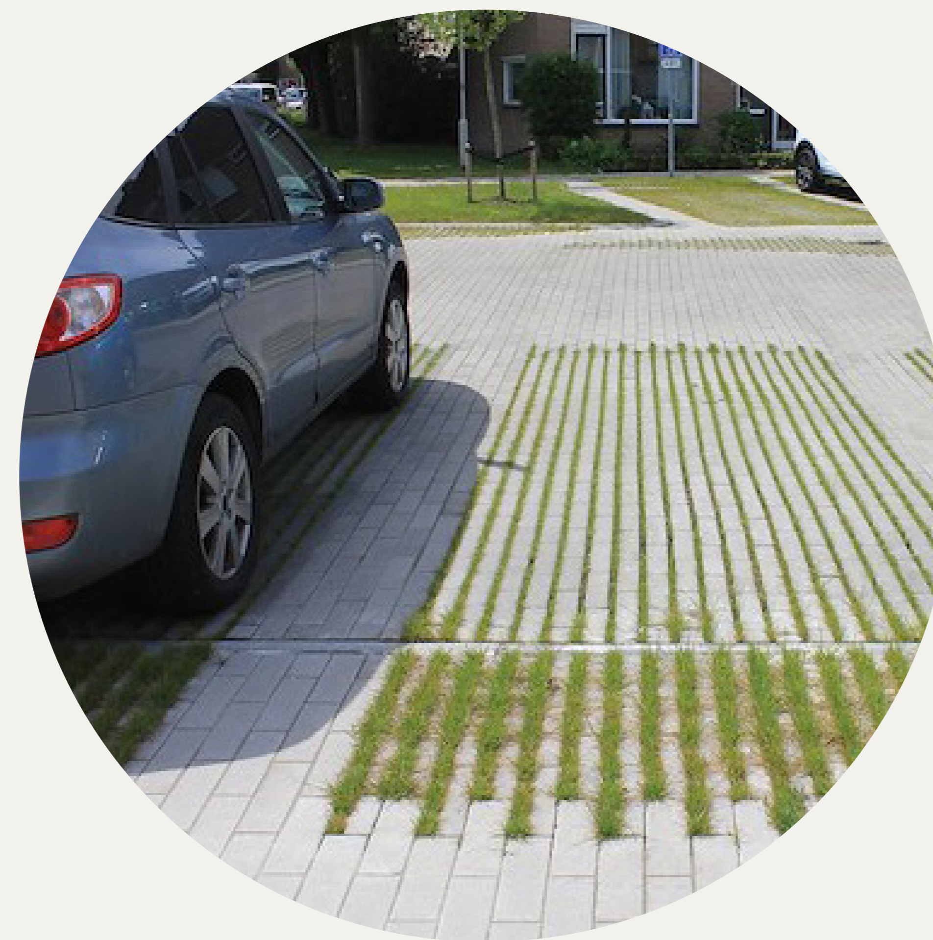
infiltratie bij parkeerplaatsen
